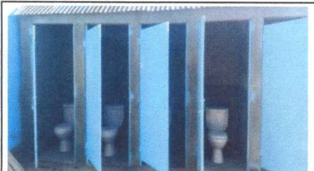
Foto 10: Cambio de Sanitarios
