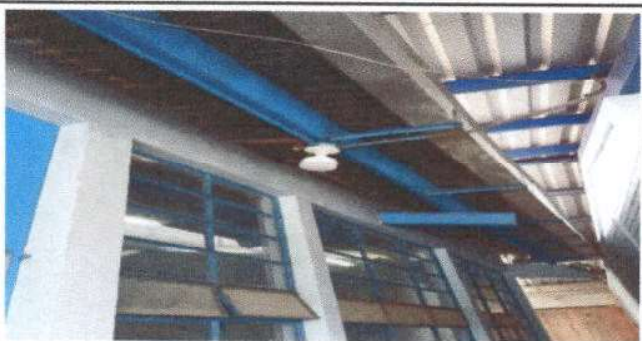
Foto 11: Sustitución de plafoneras y lamparas
