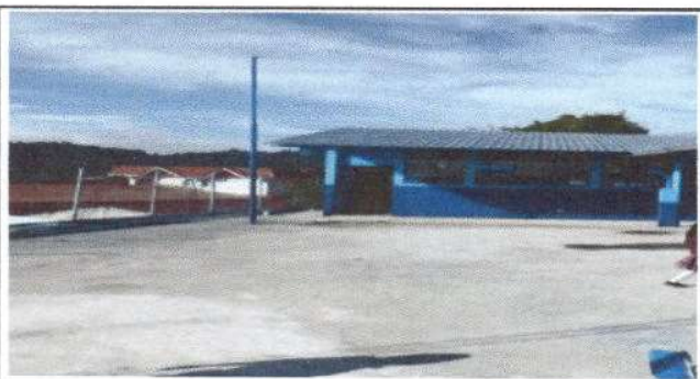
Foto 5: Reparación de piso.
