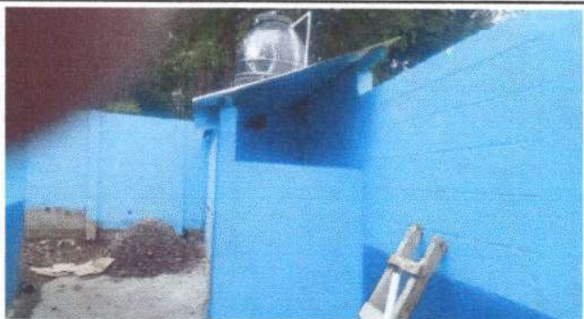
Foto 9: Reparación de paredes, techo y puerta de baños.
