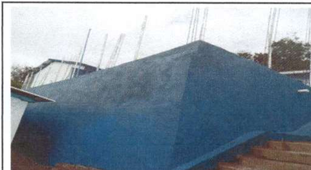
Foto 4: Reparación de muro ya por caerse al modulo que ocupa párvulos.
