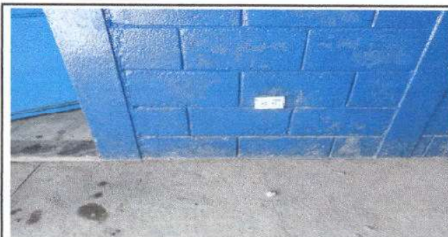
Foto 12: Reparación de alambrado eléctrico y sustitución de tomacorrientes
