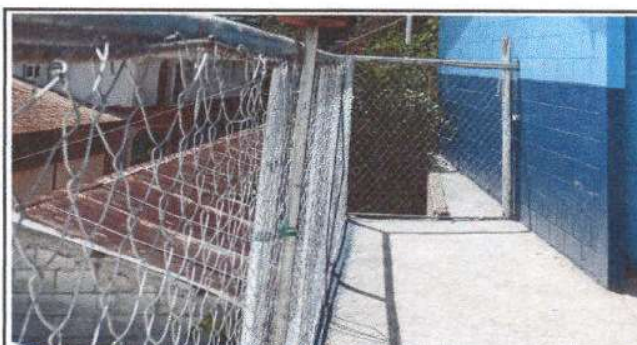
Foto 6: Reparación de piso.
