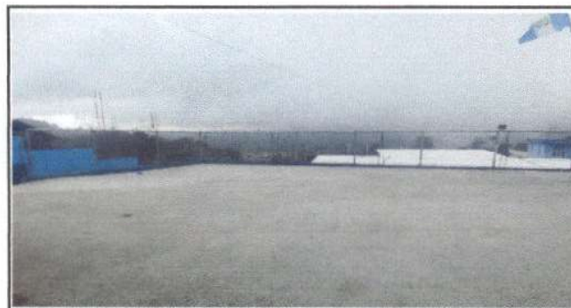
Foto 6: Reparación de tubo hg y malla galvanizada
