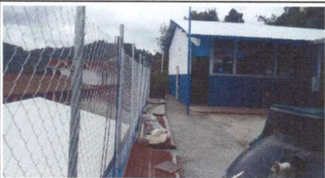
Foto 3: Reparación de muro.
